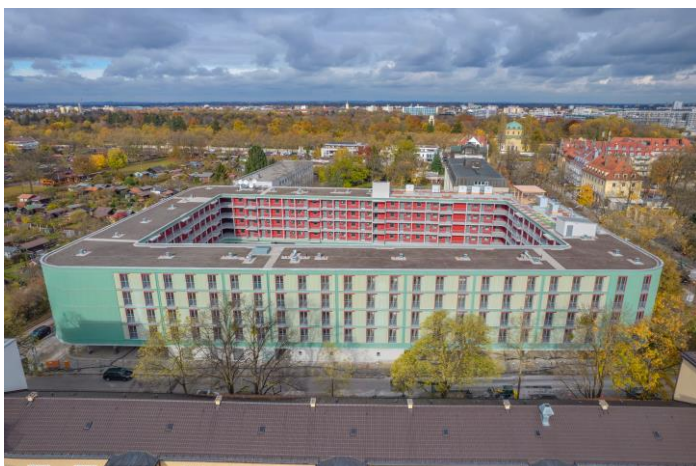
BU: Nachverdichtung im Holzbau mit dem Projekt „Dante II“: Auf dem 10.500 m 2 großen Reinmarplatz unweit des Dantebades entstanden durch Parkplatzüberbauung 144 neue Wohneinheiten (Copyright: Huber & Sohn GmbH & Co KG)
