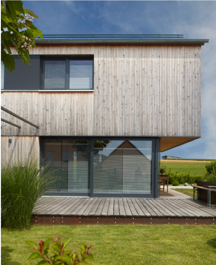
Für Wohnungsbau- und Gewerbebaugesellschaften Mehrgeschossige Wohn- und Gewerbebauten können genauso in Holzbau- oder Holzhybridbauweise realisiert werden wie die Sanierung bestehender Wohn- und Gewerbebauten.
