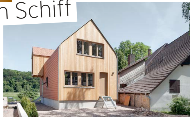
Ein Sockel aus Beton schützt die Holzkonstruktion vor Hochwasser. Die Lärchenbretter der Fassade und die Tür aus Eiche sind unbehandelt und entwickeln eine Schutzschicht.
