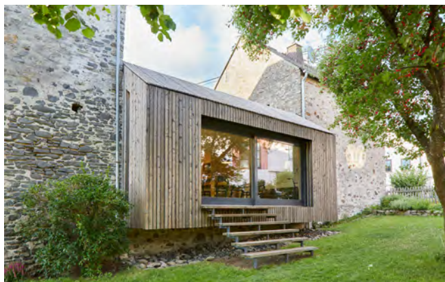
Mit der Zeit vergrauen die Holzlatten und nähern sich farblich an die Bruchsteine an. Ein sensibel eingefügter Anbau.
