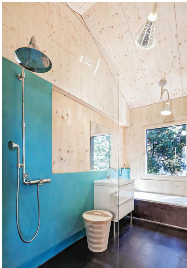
Pragmatisch und kostengünstig – nur wo es wirklich feucht werden kann, schützt ein Putz das Holz.
