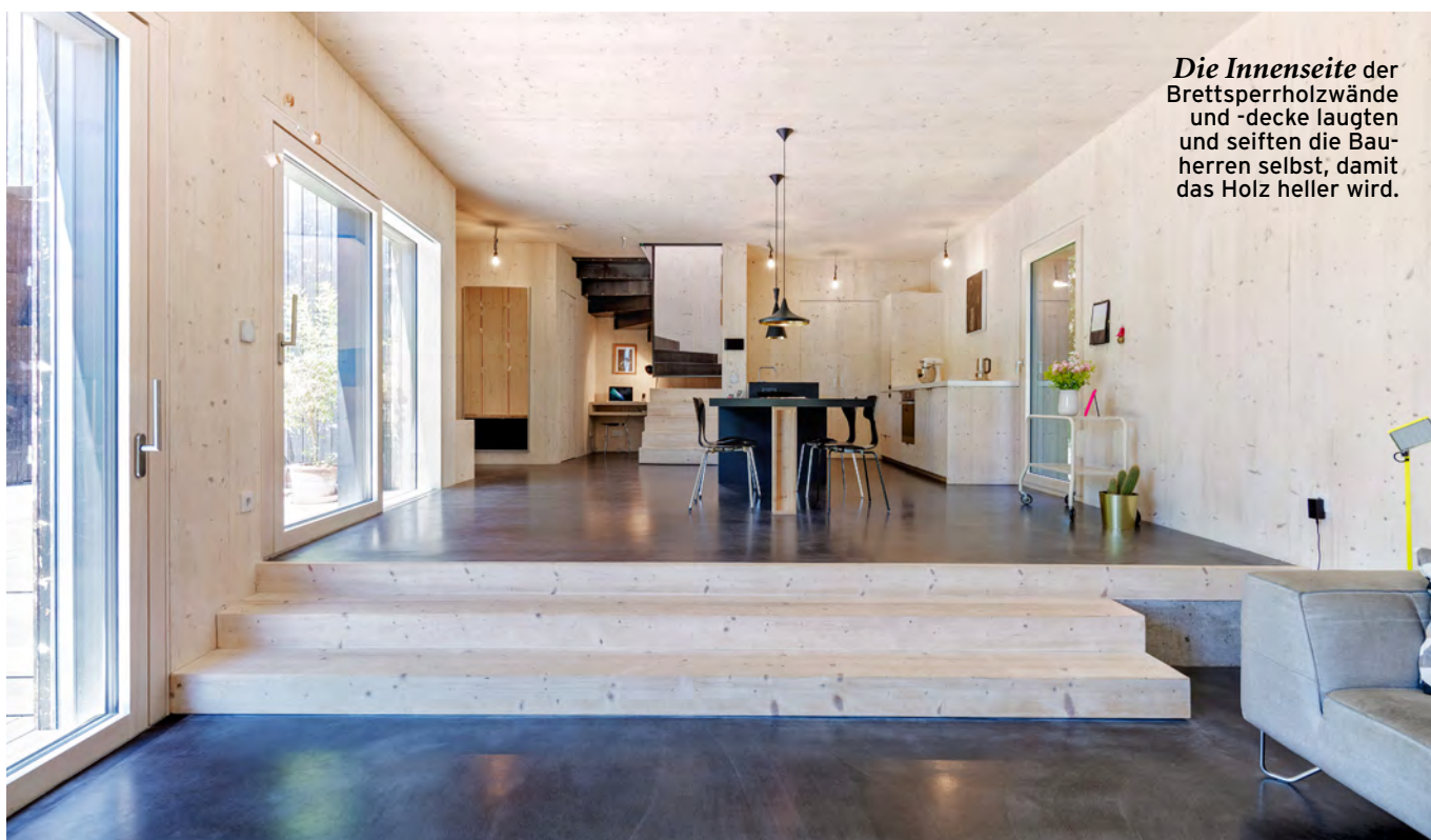
Pragmatisch und kostengünstig – nur wo es wirklich feucht werden kann, schützt ein Putz das Holz.
