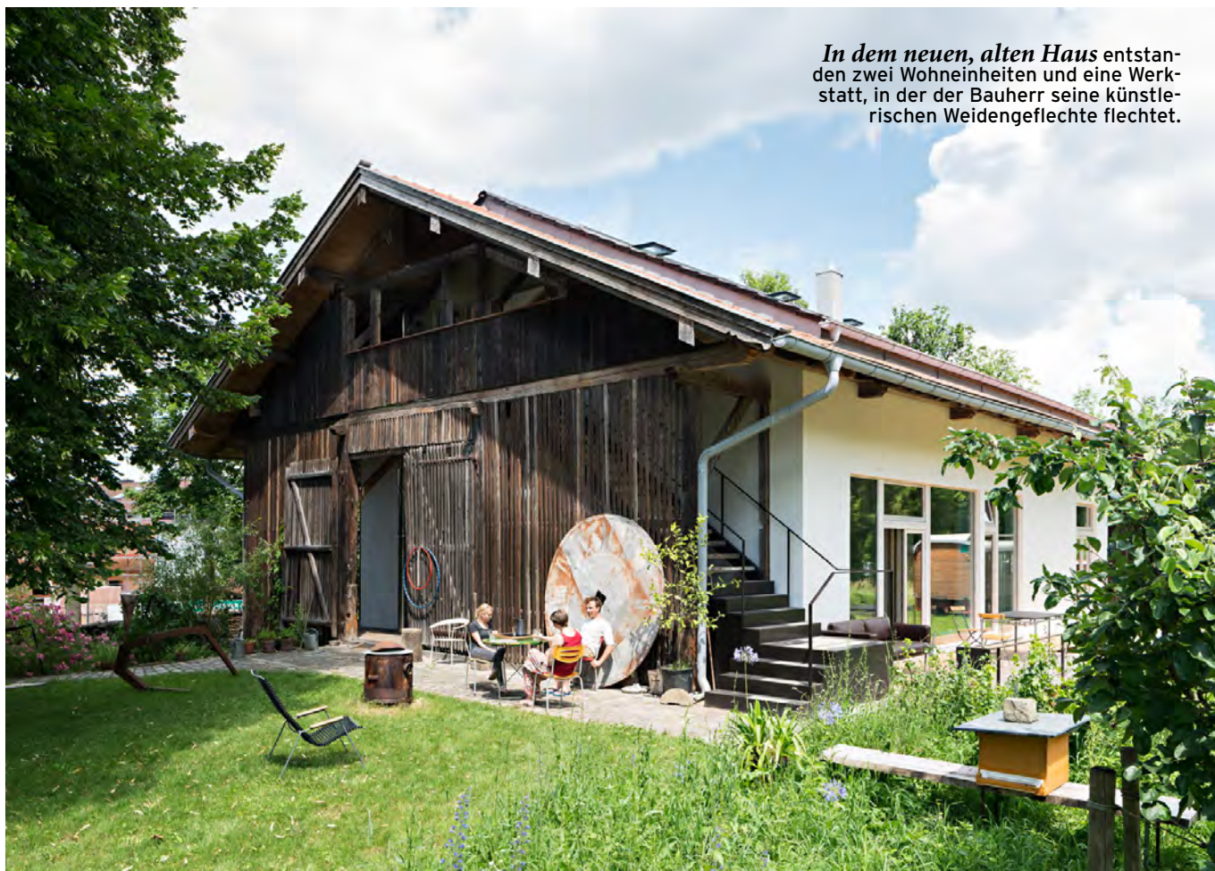
Zwischen altem Fachwerk und neuer Außenwand entstand ein Zwischenraum, der als Sitzplatz und Erschließung dient.
