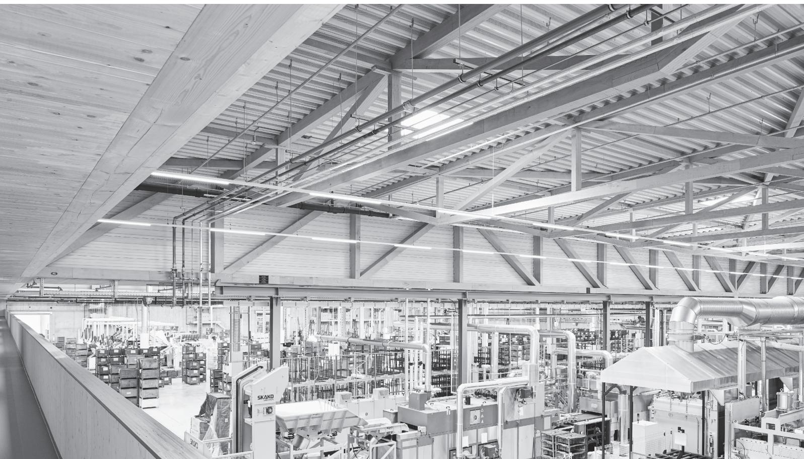
Das erreichten die Ingenieurinnen und Ingenieure unter anderem, indem sie die horizontal wirkenden Lastanteile der Druckkräfte der Diagonalen über ein Zwischenstück (mittiger Block über der Stütze, seitlich angeschrägt mit unterseitiger Verzahnung) direkt koppelten.
