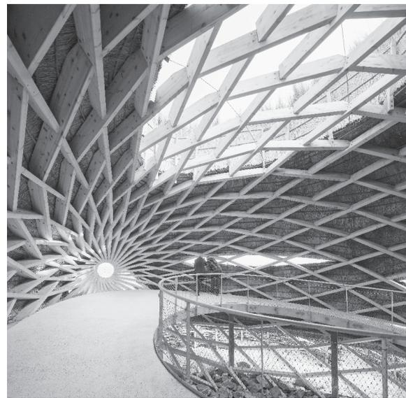
Insgesamt besteht das Observatorium aus 402 Teilen, in Finnland
