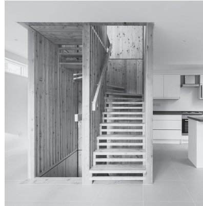
Waing Gohil and Potter Architects entwarfen für ein Haus in London eine Wangentreppe aus vorfabrizierten Massivholzelementen mit einer Decklage aus Lärchenholz.
