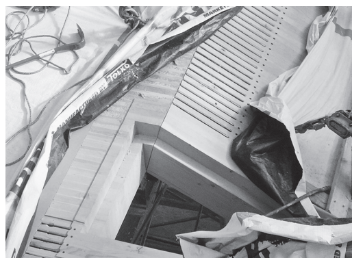
Die Treppenläufe aus Brettschichtholz sind mithilfe von eingeklebten Stahlschwertern an den Holzpodesten befestigt.
