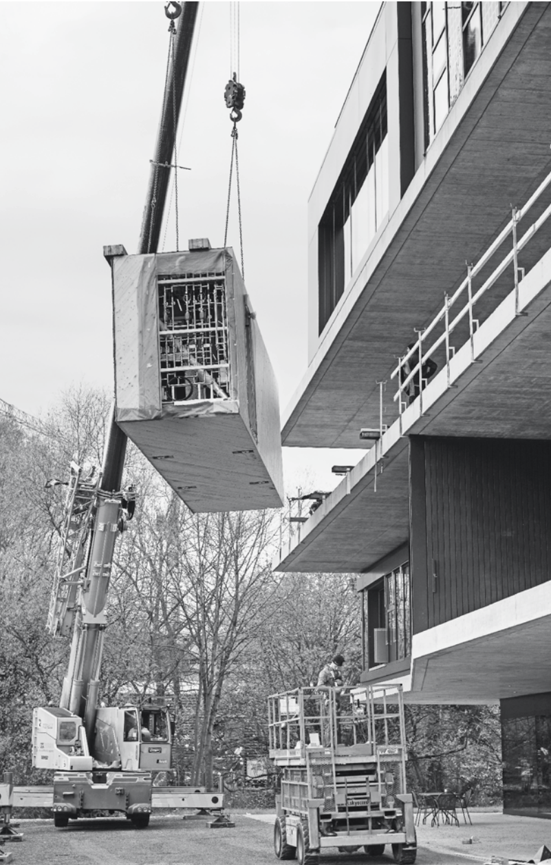
In diesem Forschungsmodul der Empa wird das recycelbare Bauen erprobt.
