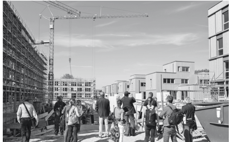
Im Prinz Eugen Park in München entstehen zahlreiche Wohnbauten in Holzbauweise. Dabei zeigt sich, wie variantenreich effizienter und konkurrenzfähiger Holzbau sein kann.
