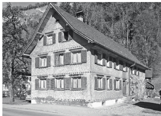
Haus in Kennelbach
