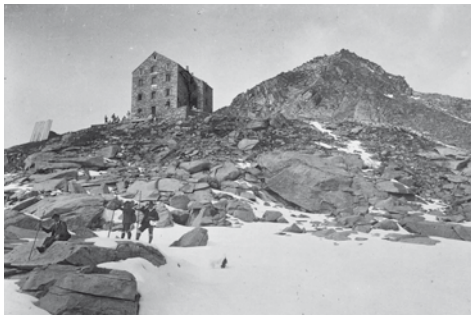
1904 Neue Prager Hütte/A (2) Diese Hütte ist Ausgangspunkt für Touren auf den Großvenediger. Sie wurde 2004 saniert und steht seit 2013 unter Denkmalschutz.
