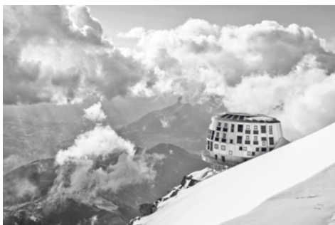
2013 Refuge du Goûter/FR (8) Die futuristisch anmutende Schutzhütte ist ein vierstöckiger solarbetriebener, mit Edelstahlplatten verkleideter Holzbau. Die Unterkunft liegt am Weg zur Spitze des Mont Blanc auf 3.855 Metern Seehöhe.
