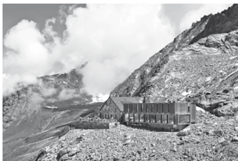
2010 Moiry-Hütte (Cabane de Moiry)/CH (9) Die Hütte liegt am Rande des Glacier de Moiry auf 2.825 Metern Seehöhe. Der Anbau an die steinerne Bestands-hütte wurde von Baserga Mozzetti Achitetti geplant, aus vorgefertigten Holzrahmenelementen errichtet und mit Kupferplatten verkleidet.
