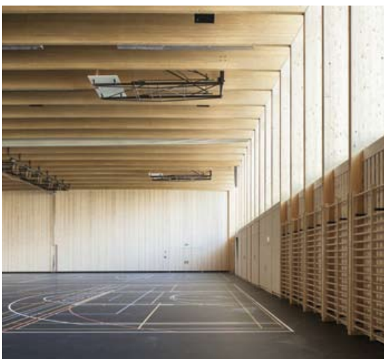
← Konsequente Vorfertigung: Für die Akustikelemente war deshalb in der Halle kein Gerüst mehr nötig.
