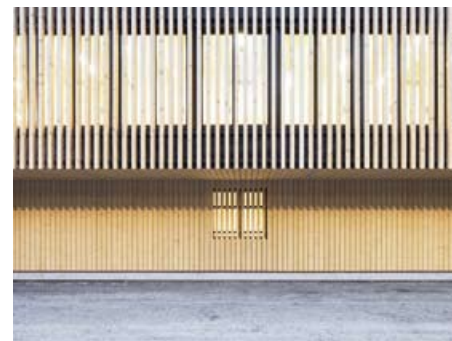
↑ Holzrahmenbau-Elemente mit 20 cm Mineralfaserdämmung bilden die Gebäudehülle. Unbehandeltes Fichtenholz dient als Vertikalschalung.
