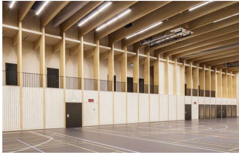
↑ Die große Halle lässt sich bei Bedarf in vier Einzelhallen unterteilen.
