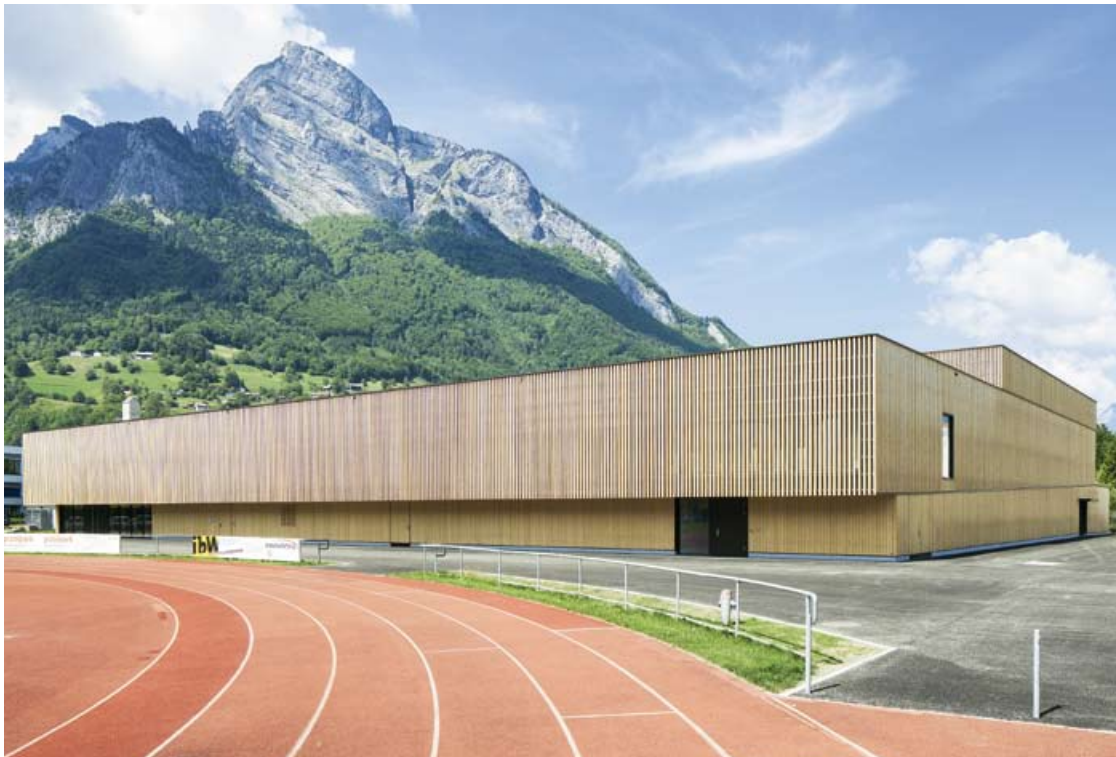
↑ Rund 1250 m 3 Holz aus schweizerischen Wäldern wurden verbaut. Das bindet 850 t CO 2 .
