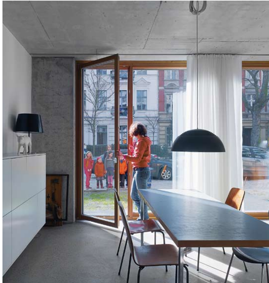
↑ Das Erdgeschoss ist aus Stahlbeton gefertigt und außen mit Lärchenholz bekleidet.
